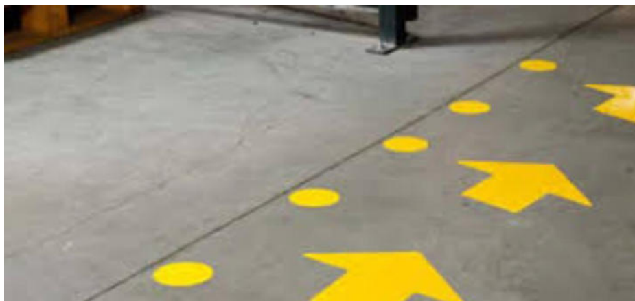
Gráfico N° 15. Señalización en pisos.
